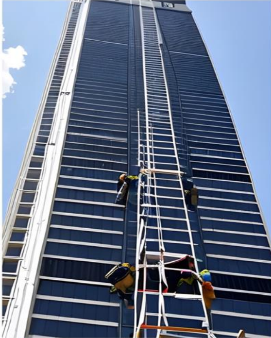
Gebouwinspecties worden gedaan met behulp van bijvoorbeeld gondels.
