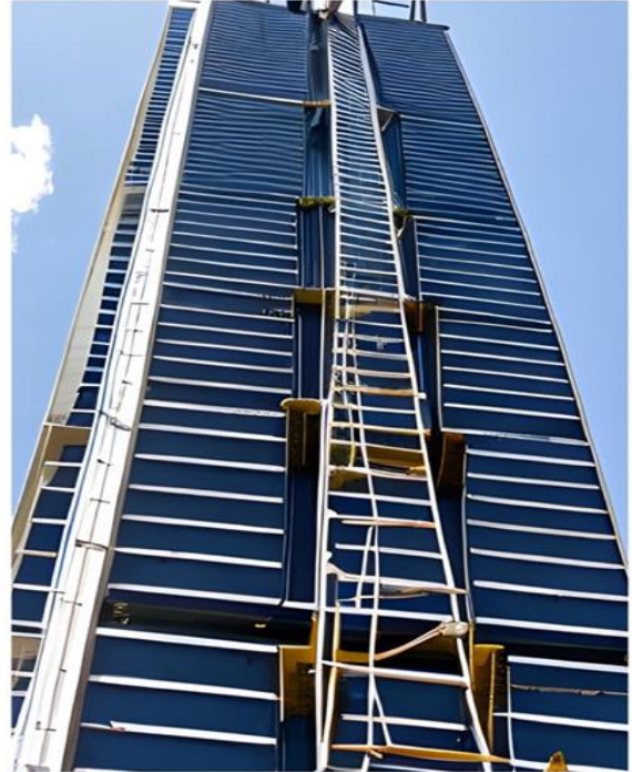
Op deze manier hoge gebouwen inspecteren vereist mankracht, tijd en geld. Bovendien kan het ook flink misgaan.
